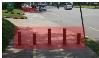
Gambar 5. Tiang Pembatas (Bollards) pada Jalur Pejalan Kaki CBD Bintaro Jaya
